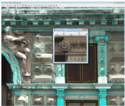
Hohe Detailerkennbarkeit im Bild
